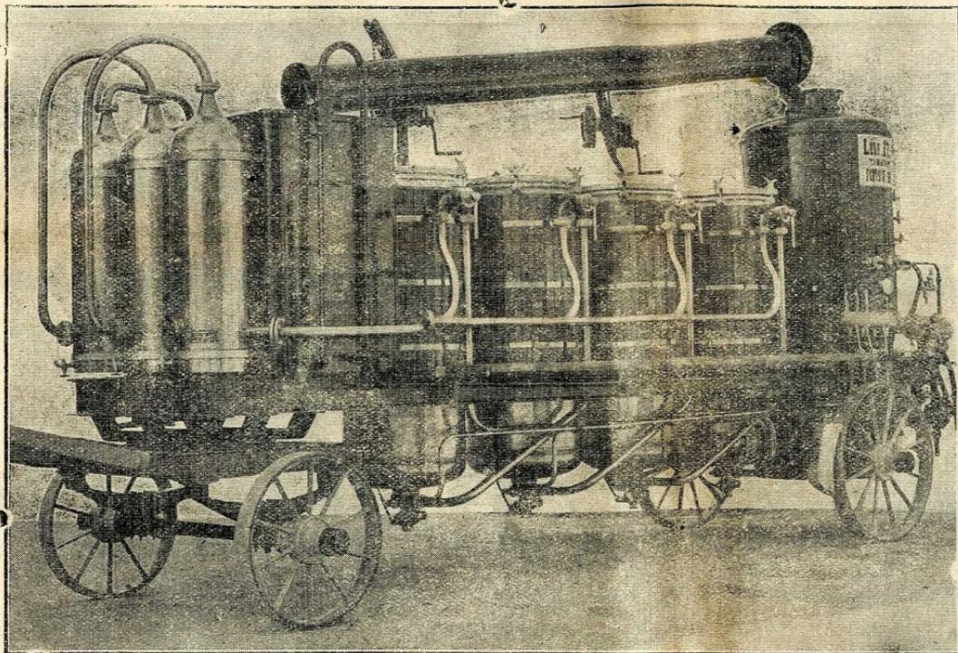
Appareils roulants et fixes. Rectificateurs, réfrigérants de gros volume, construits pour distillation accélérée, pouvant distiller jusqu'à 35.000 kgs de marc en 24 heures avec appareil roulant
